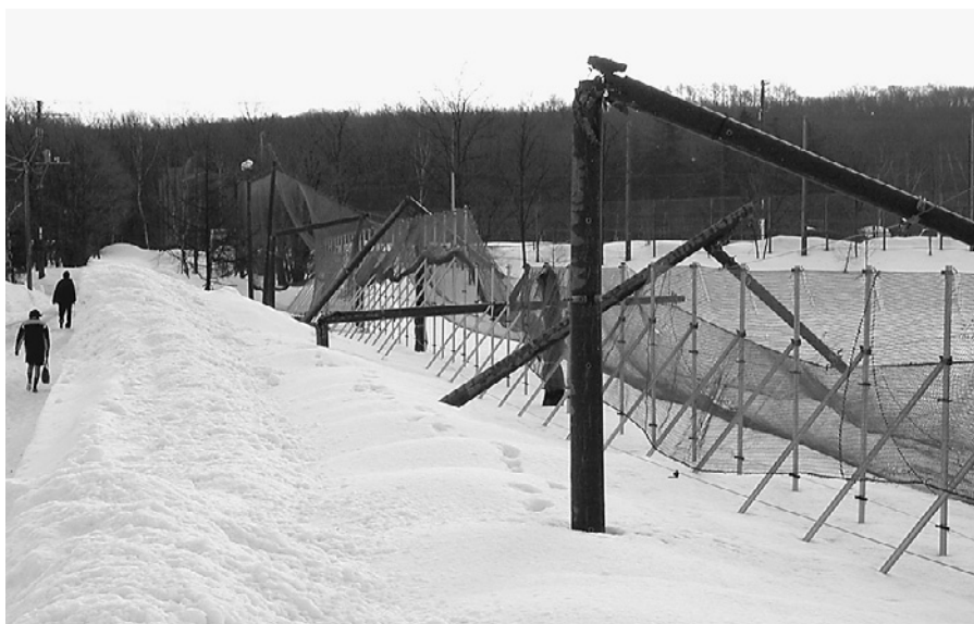
写真4 着氷による鉄筋コンクリートポールの倒壊
