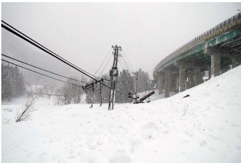
写真 6. 雪崩でなぎ倒された電柱とデブリで埋まった県道：石坂雅昭撮影
