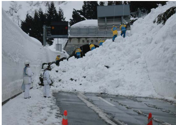
写真 1. 雪崩：町田建設提供
