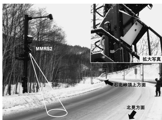
図 5 観測機器の設置状況と装置拡大写真。観測機器は視程計が設置された道路管理用の鉄塔に取り付けた。
