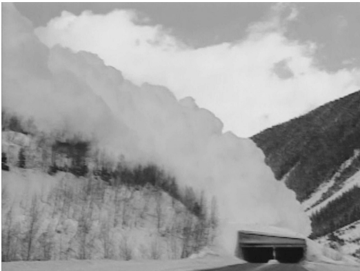
図 10 人工雪崩とスノーシェッド.
