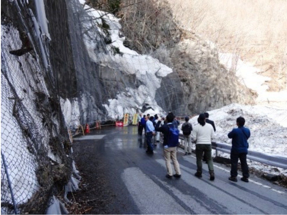
写真 7 . 甲府市古関町で発生した道路雪崩の調査
